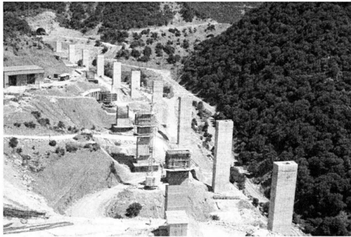
Εικόνα 3.5 Κατασκευή μεσόβαθρων
