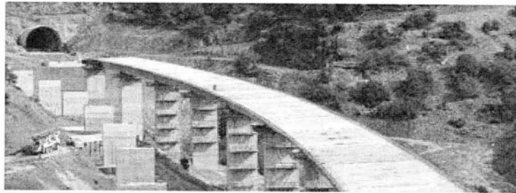
Εικόνα 3.3 Ολοκλήρωση δεξιού κλάδου
