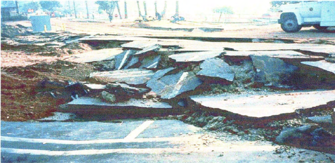
Εικόνα 2.2 Μία από τις λίγες περιοχές ρευστοποίησης του εδάφους στη Παραλία του Ρεντόντον (Kings Harbour Marina in Redondo Beach), 27 μίλια από το επίκεντρο
