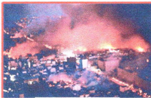
Εικόνα 2.5 Πάνω από 300 πυρκαγιές ξεκίνησαν από διαρροή φυσικού αερίου σε αγωγούς που υπέστησαν ρήξη
