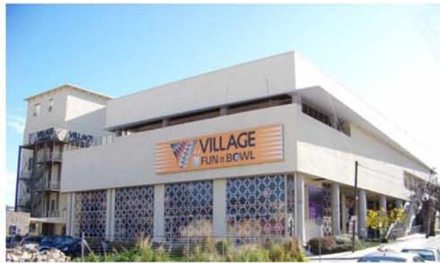
Εικόνα 12: «Κτίριο πρώην Κυλινδρόμυλων Λούλη», πηγή: Καρανάσου Ευσταθία
