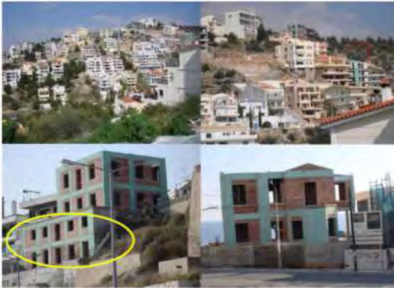
Εικόνα 2.7: Αυθαίρετα κτίρια στα οποία ξεπερνιέται η επιτρεπόμενη επιφάνεια των ορόφων βάσει του ΣΔ (Dimopoulou & Zentelis, 2008)
