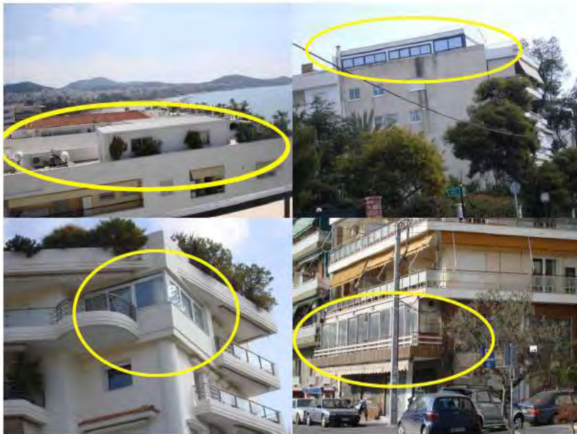
Εικόνα 2.11: Παράνομες κατασκευές στις οροφές των κτιρίων και αυθαίρετο κλείσιμο των μπαλκονιών (Dimopoulou & Zentelis, 2008)
