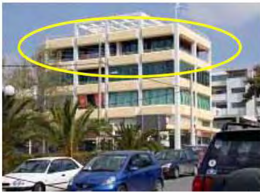
Εικόνα 2.3: Ανολοκλήρωτος όροφος λόγω της ΜΣΔ (Dimopoulou & Zentelis, 2008)
