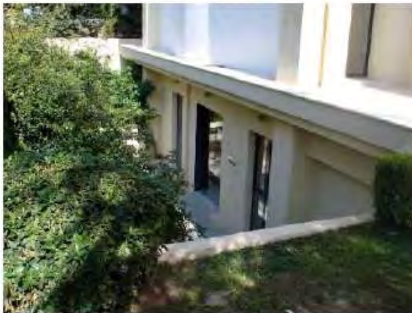
Εικόνα 2.9: Κτίριο στο οποίο το υπόγειο του μετατράπηκε σε γραφείο (Dimoroulou & Zentelis, 2008)
