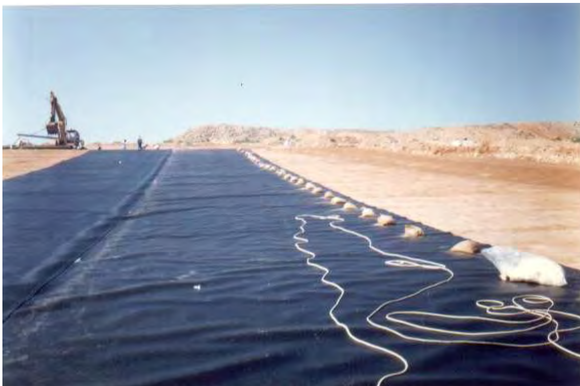
Φωτογραφία 3: Στεγανοποίηση πυθμένα με συνθετική γεωμεμβράνη HDPE
