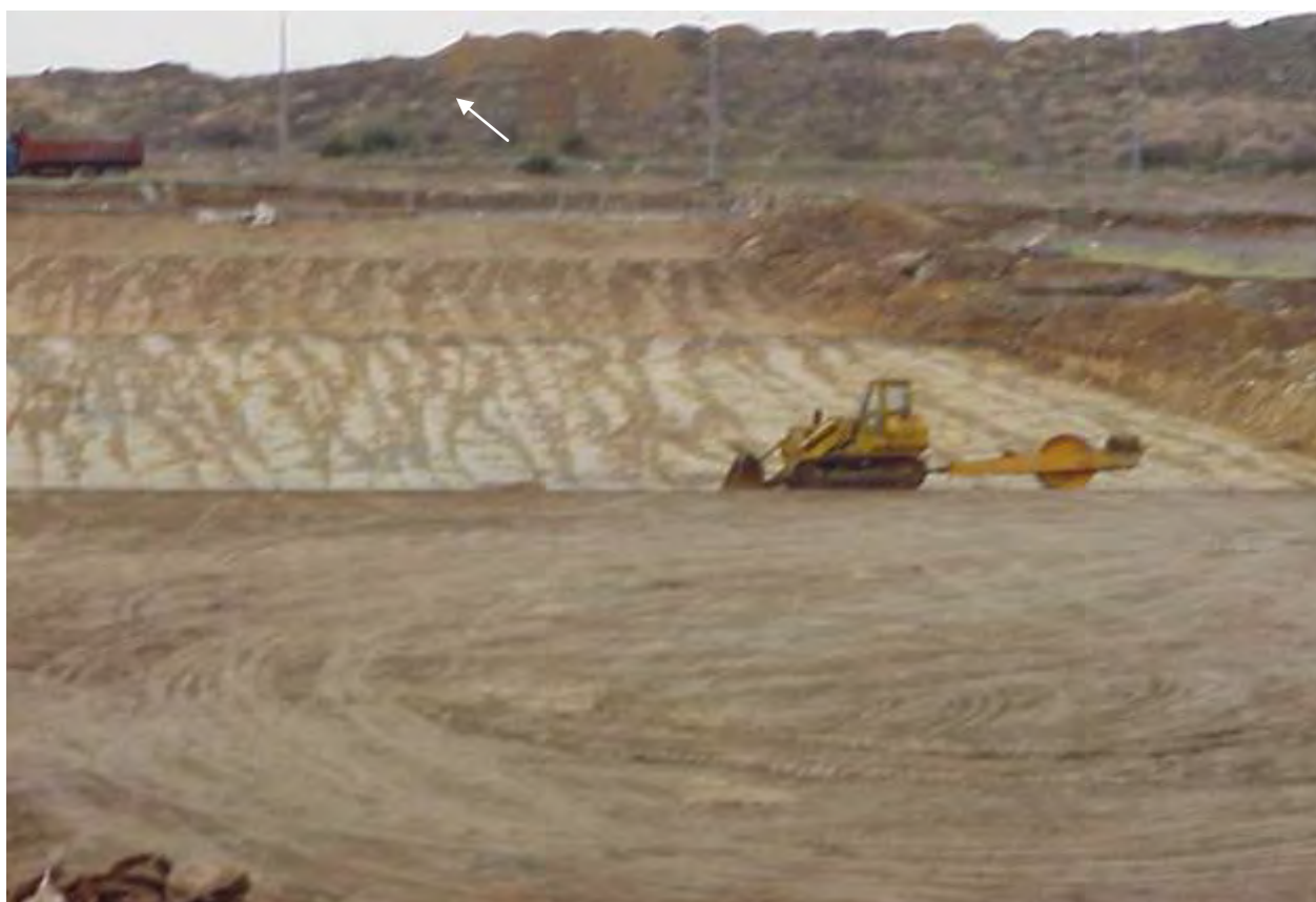
Φωτογραφία 2: Στεγανοποίηση πυθμένα ΧΥΤΑ (έργα συμπίκνωσης αργίλου)
