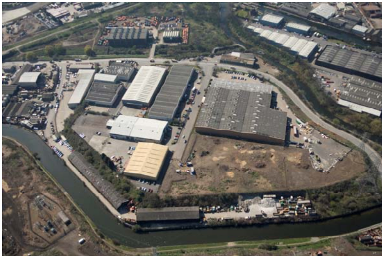
Εικόνα 34: Αεροφωτογραφία Ολυμπιακού Σταδίου, Νοέμβριος 2007
