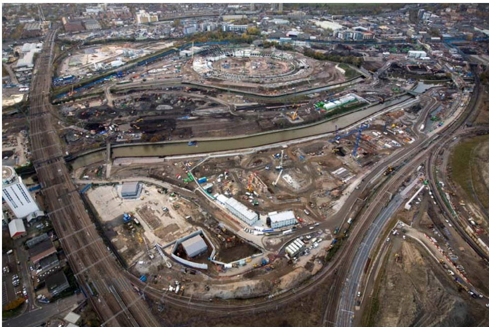
Εικόνα 39: Αεροφωτογραφία (α) Κέντρου Aquatics, Νοέμβριος 2008
