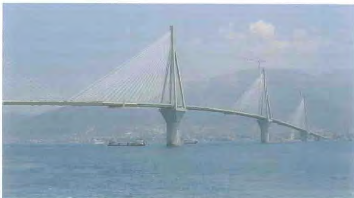
Καλωδιωτή Γέφυρα Ρίου - Αντιρρίου
