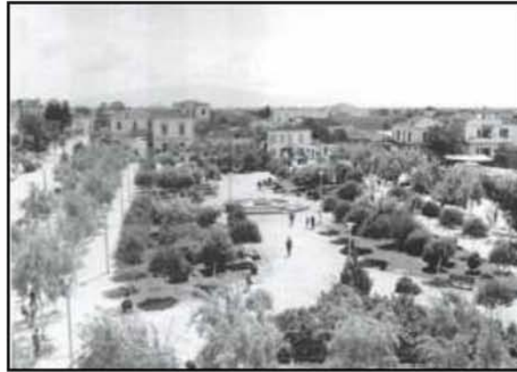
Εικόνα 20: Άποψη της Κεντρικής πλατείας- τότε πλατείας Σάπκα, το 1935 (www.larissa-dimos.gr)
