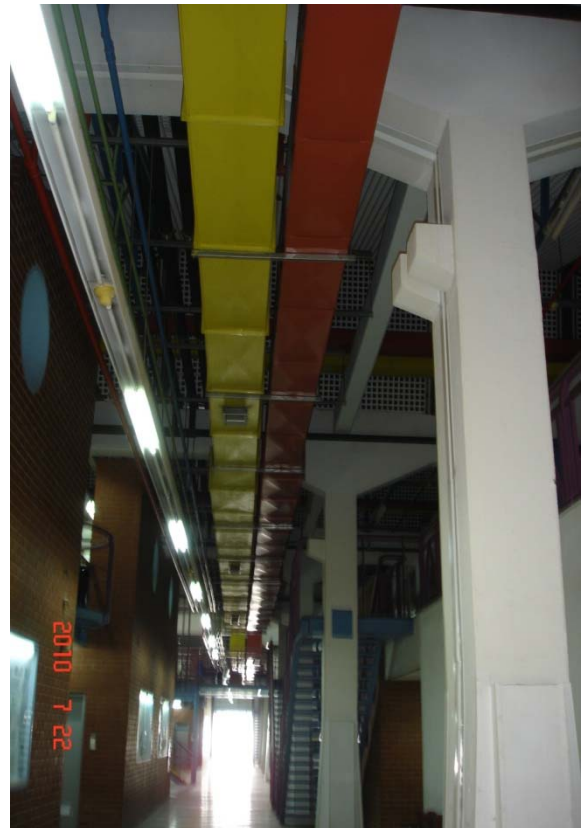
Εικόνα 86. Αεραγωγοί διανομής κλιματιζόμενου αέρα. στο διάδρομο Ο κίτρινος αεραγωγός είναι προσαγωγής ενώ ο κόκκινος είναι ο αγωγός εξαερισμού.
