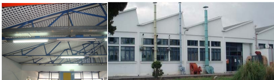
Εικόνα 50: Όψη οροφής κτιρίου εσωτερικά (αριστερά) και εξωτερικά (δεξιά)
