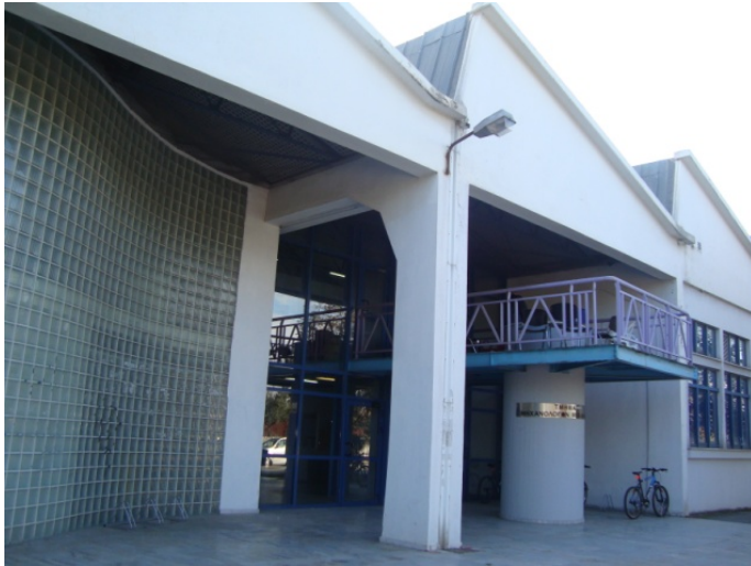
Εικόνα 52: Εξωτερική όψη ΒΔ τοίχου από υαλότουβλα
