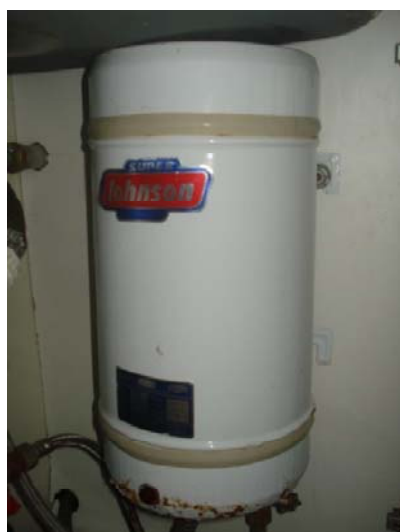
Εικόνα 95. Ηλεκτρικός θερμοσίφοντας χωρητικότητας 5lt και ηλεκτρικής ισχύος 1.5 kW.
