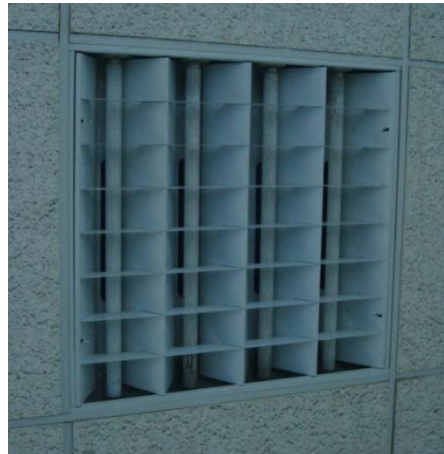
Εικόνα 92: Φωτιστικό σώμα τύπου 1 – Αποτελείται από 4 λαμπτήρες T8 (4*18W)
