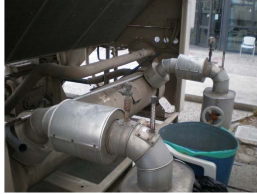
Εικόνα 91. Πίσω όψη ψυκτικής μονάδας. Διακρίνονται ο εξατμιστήρας και η είσοδος και έξοδος του νερού ψύξης
