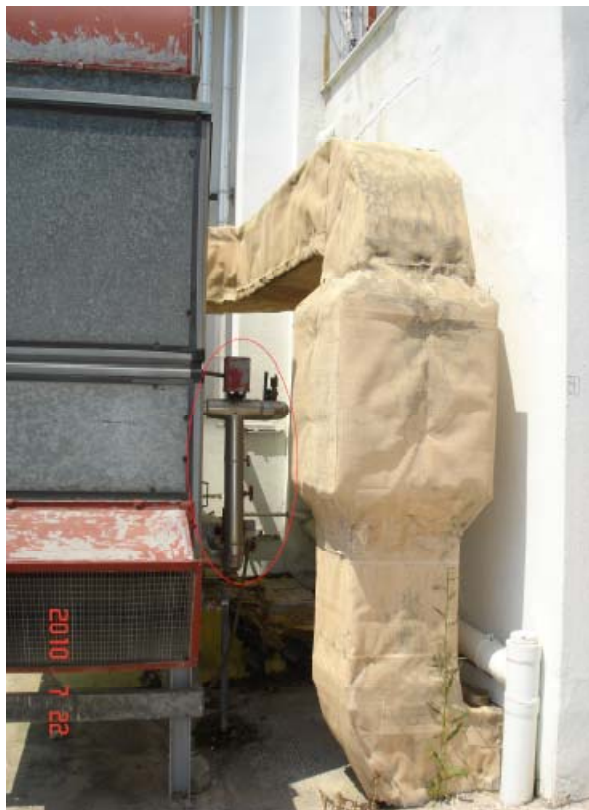
Εικόνα 84. Είσοδος αέρα θέρμανσης-ψύξης αμφιθεάτρου (αριστερά) και αισθητήρας ελέγχου θερμοκρασίας νερού (δεξιά)
