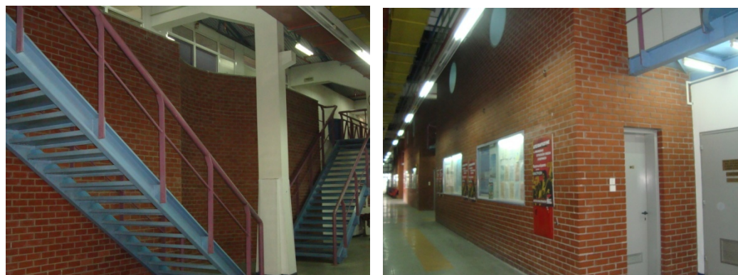
Εικόνα 51: Εσωτερικός τοίχος από οπλισμένο σκυρόδεμα με επένδυση διακοσμητικού τούβλου
