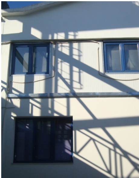
Εικόνα 53: Εξωτερική όψη ΝΑ τοίχου από γυψοσανίδα με εξωτερική μόνωση υαλοβάμβακα
