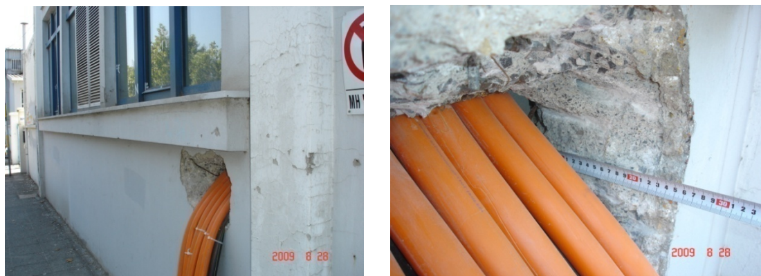
Εικόνα 49: Εξωτερικός τοίχος κτιρίου από οπλισμένο σκυρόδεμα, πάχους 25cm, χωρίς μόνωση
