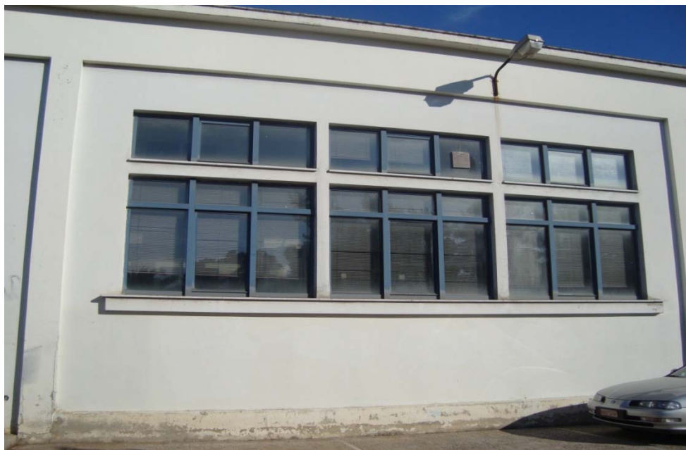
Εικόνα 57: Παράθυρα τύπου 1 και 2 περιμετρικά του κτιρίου
