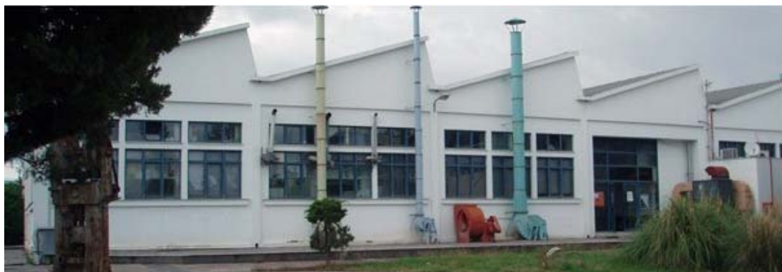
Εικόνα 101. Νοτιοανατολική όψη του κτιρίου – Κεκλιμένη μεταλλική στέγη
