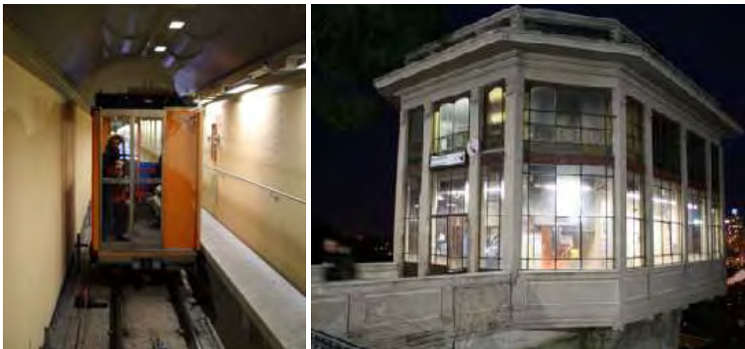
Εικόνα 5.2: Άποψη 2 δημοσίων ανελκυστήρων στην πόλη της Γένοβα
