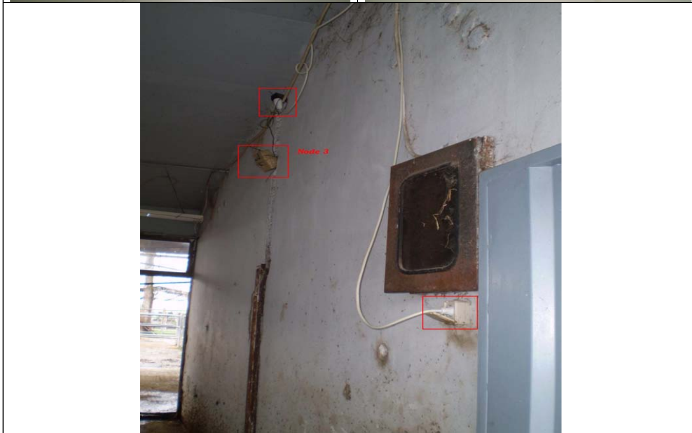
Φωτογραφία με ανοιχτό και κλειστό το περίβλημα του Node 3 που τοποθετήθηκε στο χώρο με τις αγελάδες από την Δανία.
