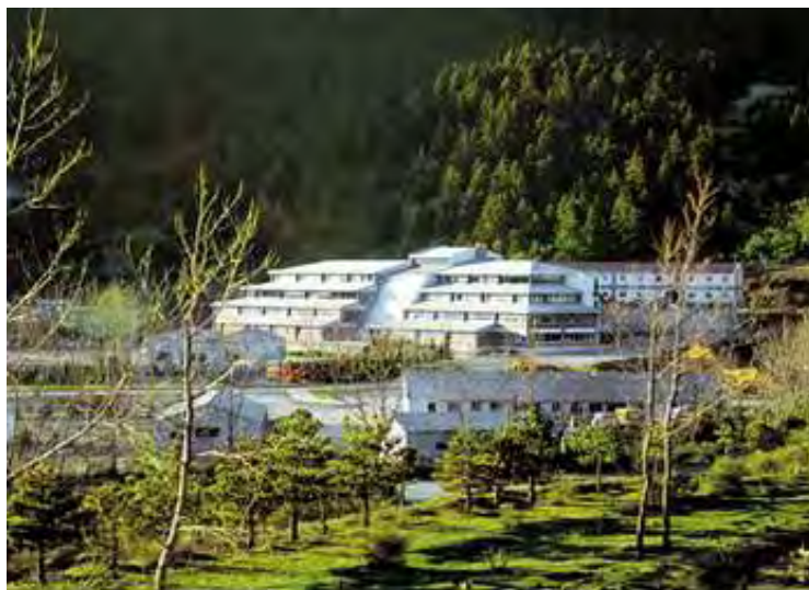
Εικόνα 20. Εγκαταστάσεις Vagonetto, Άμφισσα
