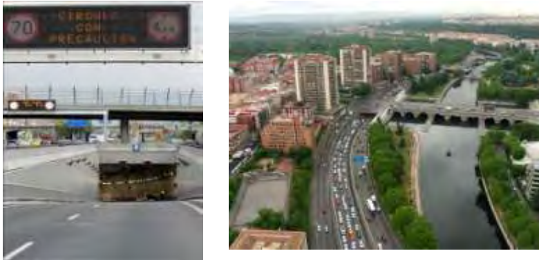
Εικόνα 2 Υπόγειος δρόμος M-30 στη Μαδρίτη
