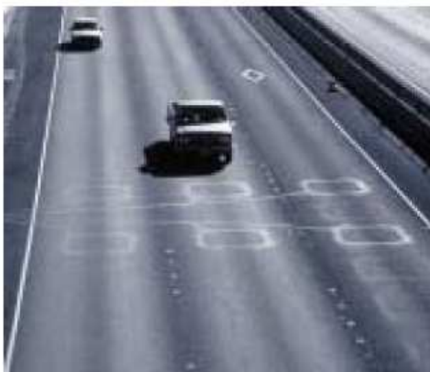
Εικόνα 3.1: Ζεύγη μαγνητικών ανιχνευτών βρόχου
