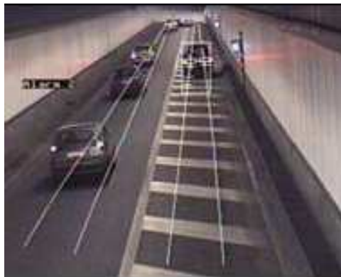
Εικόνα 3.9: Ανίχνευση σταματημένου οχήματος σε σήραγγα
