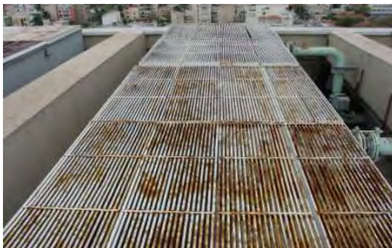
Εικόνα 10. Σταγονοσυλλέκτες πύργου ψύξης
