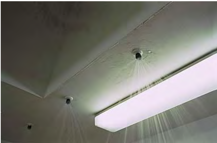
Εικόνα 2. Καταιονητήρες πυρόσβεσης
