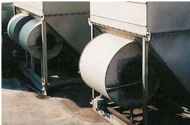
Εικόνα 9. Ανεμιστήρες πύργου ψύξης
