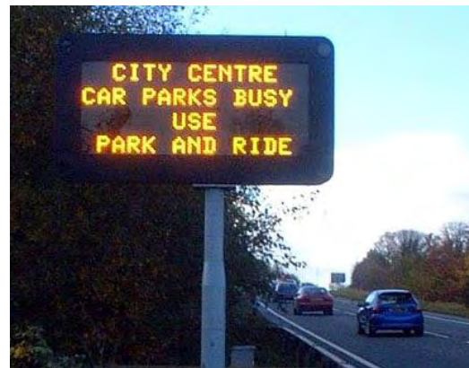
Εικόνα 16: Ηλεκτρονική πινακίδα VMS
