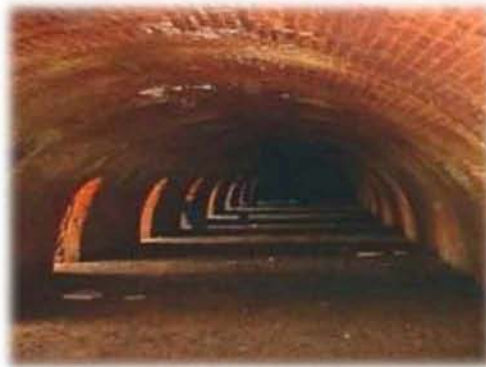
Εικόνα 11: Η κάμινο συνεχούς καύσης τύπου Hoffman.
