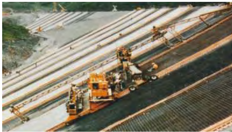
Εικ. 9: Τυπικό φράγμα CFRD υπό κατασκευή
