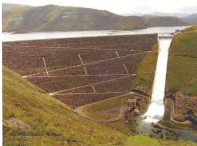
Εικ. 17: Η υπερχειλίση του Mohale μετά τις πλημμύρες.
