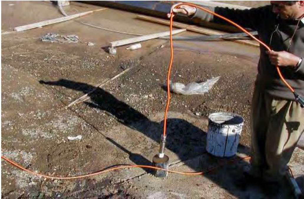
Εικ. 14: Τοποθέτηση ηλεκτρικών πιεσομέτρων.
