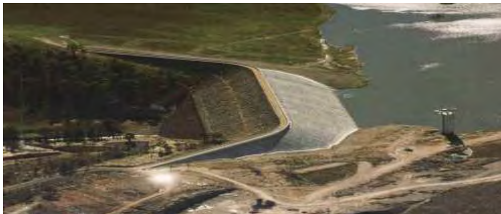
Εικ. 5: Φράγμα Gathright, Virginia , Λιθόρριπτο με αργιλικό πυρήνα
