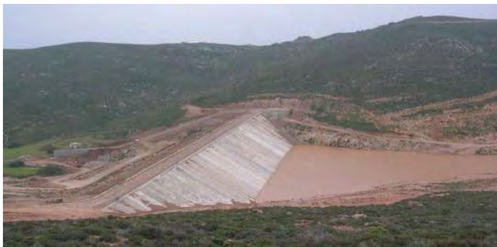
Εικ. 6: Λιθόρριπτο φράγμα με ανάντη πλάκα από σκυρόδεμα – Λειβάδι Πάτμου Λωδ/σου
