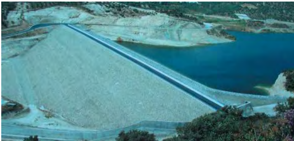
Εικ. 4: Φράγμα Φανερωμένη Μεσσαρά Ηρακλείου Κρήτης Χωμάτινο με αργιλικό πυρήνα
