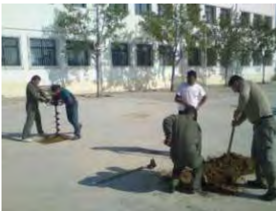
Εικόνα 8. Εργασίες προετοιμασίας της δεντροφύτευσης
