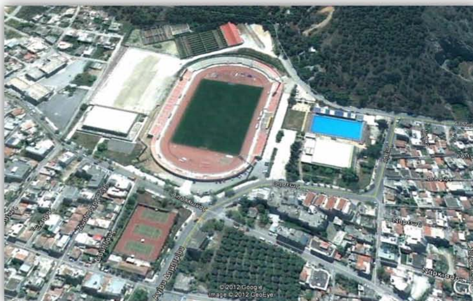
Εικόνα 2.1 Πανοραμική απεικόνιση των εγκαταστάσεων του Ε.Α.Κ του Δήμου Βόλου. (Χρήση προγράμματος Googleearth).
