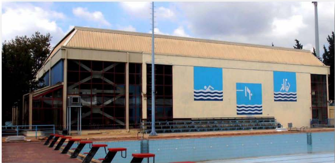
Εικόνα 2.4 Εξωτερική άποψη Κλειστού κολυμβητηρίου.
