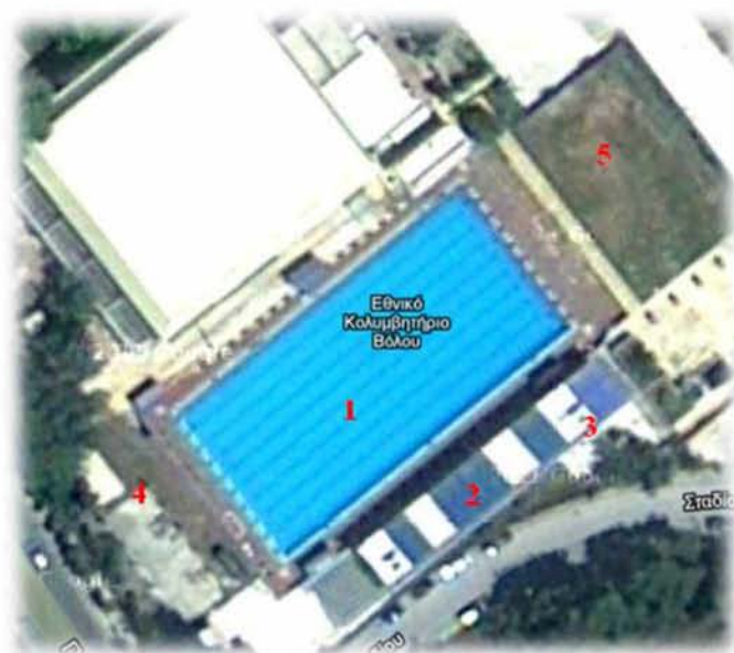
Εικόνα 2.2 Πανοραμική άποψη ανοικτού κολυμβητηρίου. (Χρήση προγράμματος Googlearth).
