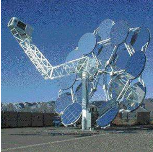
Εικόνα 3.4 Συλλέκτης Παραβολικού δίσκου (parabolic dish collectors)
