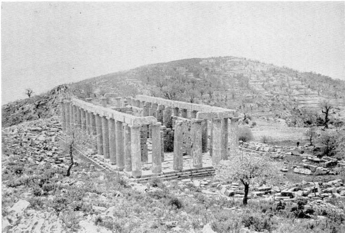
Ἡλεία. Ναὸς Ἐπικούριου Ἀπόλλωνος Βασσῶν : α. Τὸ ἐτοιμόρροπον ἐπιστύλιον παρὰ τὴν ΒΔ. γωνίαν τῆς βορείας πλευρᾶς τοῦ ναοῦ ( κάτω ὄψις ) πρὸ τῆς ἀποκαταστάσεως αὐτοῦ, β. Λεπτομέρεια τοῦ αὐτοῦ ἐπιστυλίου, γ. Βορεία πλευρὰ τοῦ ναοῦ. Διακρίνεται τὸ παρὰ τὴν ΒΔ. γωνίαν τοῦ ναοῦ ἐπιστύλιον μετὰ τὴν ἀποκατάστασιν αὐτοῦ
