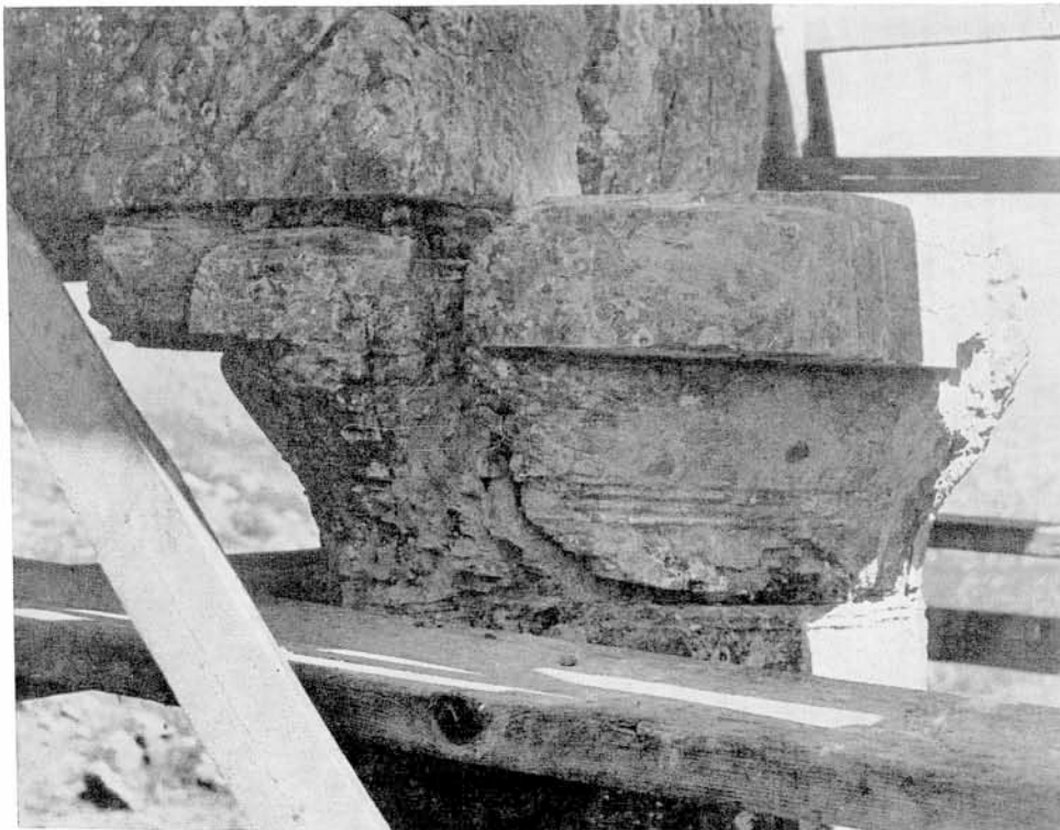
Ἡλεία. Ναός Ἐπικουρίου Ἀπόλλωνος Βασσάν : α. Τὸ κιονόκρανον τοῦ Πί ν. 175 α, β. Τὸ αὐτὸ κιονόκρανον μετὰ τὴν ἀποκατάστασιν αὐτοῦ
