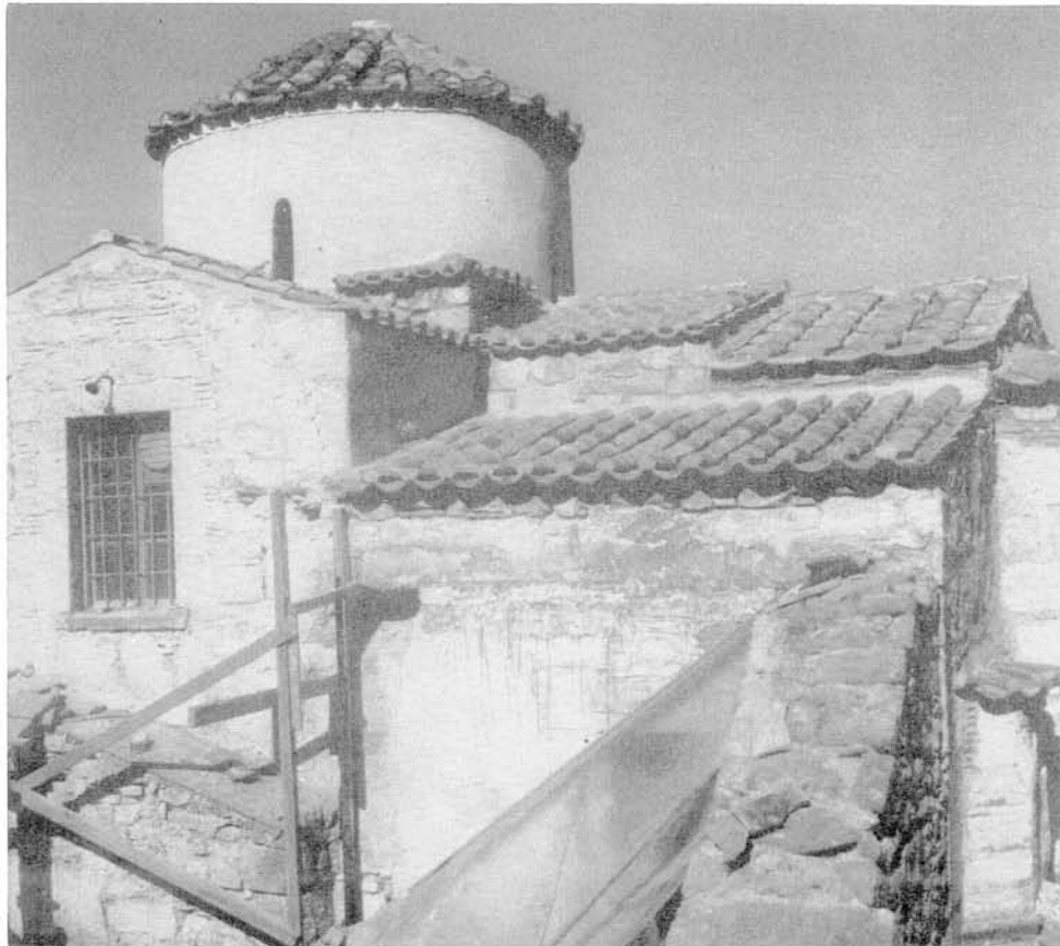
Βοιωτία: α. Χωρίον Ὑψηλάντη. Ναός Ἁγίου Νικολάου, β. Ἀκραίφνιον. Αἱ στέγαι τῶν ἀνατολικῶν χώρων τοῦ ναοῦ τοῦ Ἁγίου Γεωργίου μετὰ τὰς ἐργασίας
