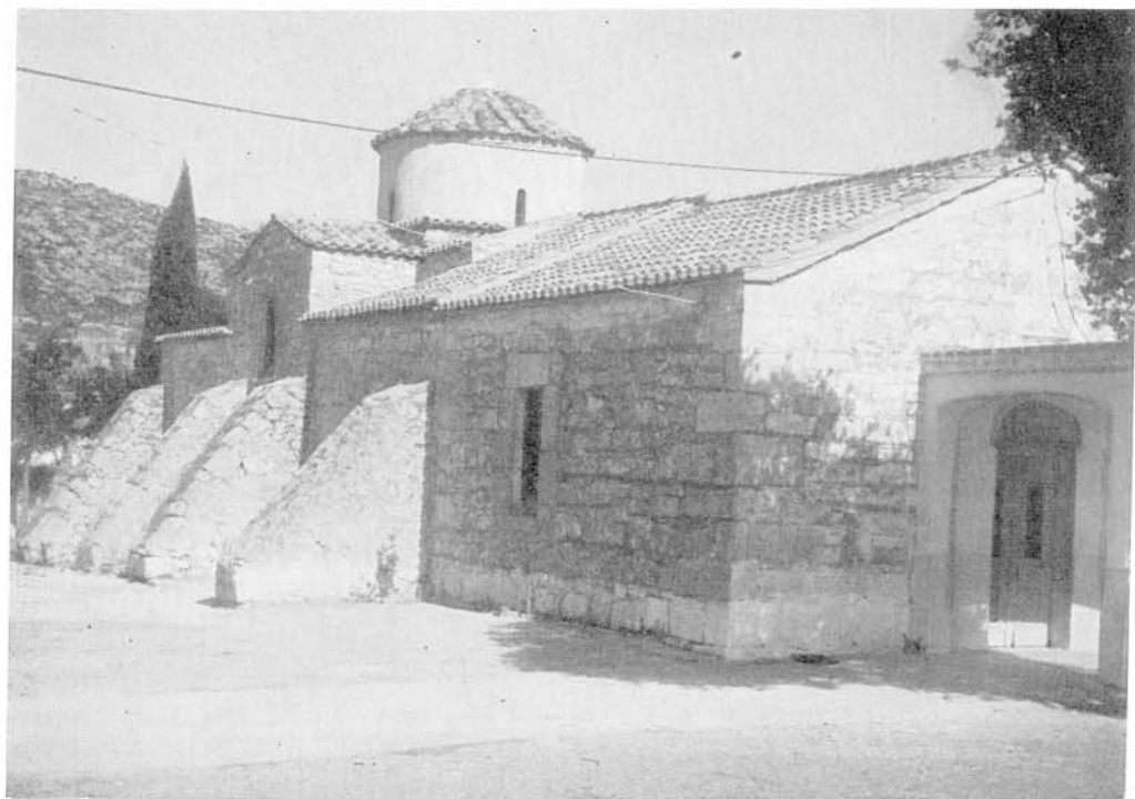
Ἀκραίφνιον. Ναός Ἁγ. Γεωργίου: α. Ὁ τροῦλλος καὶ αἱ κεραῖαι κατὰ τὰς ἐργασίας, β. Ὁ ναὸς μετὰ τὰς ἐργασίας
