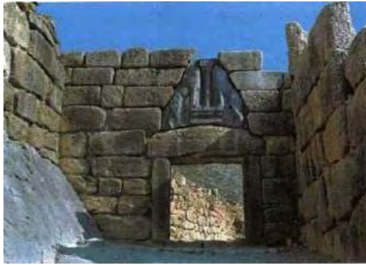
Εικόνα 1.2: Η είσοδος στην ακρόπολη των Μυκηνών. Τοίχος ηλικίας άνω των 3.500 ετών με ημικατεργασμένους ογκόλιθους (Λεγάκης, 1997).
