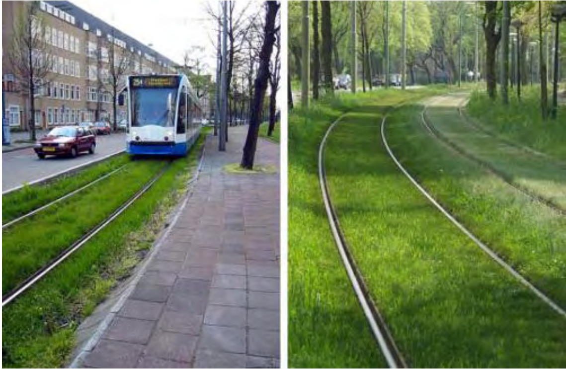
Εικόνα 3: Πράσινος διάδρομος κίνησης του τραμ Πηγή: http://walyou.com
