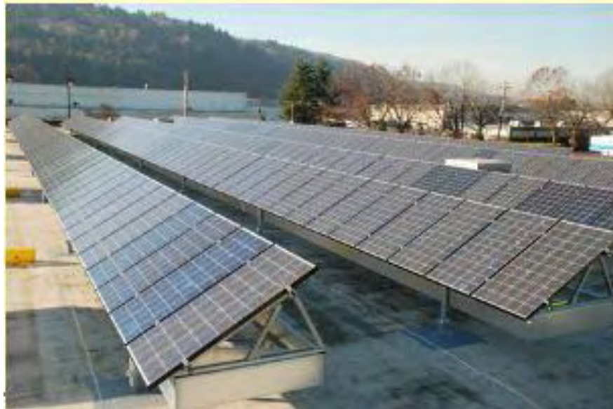
Εικ. 6.10: Τοποθέτηση Φ/Β πλαισίων στην οροφή κτιρίου.
