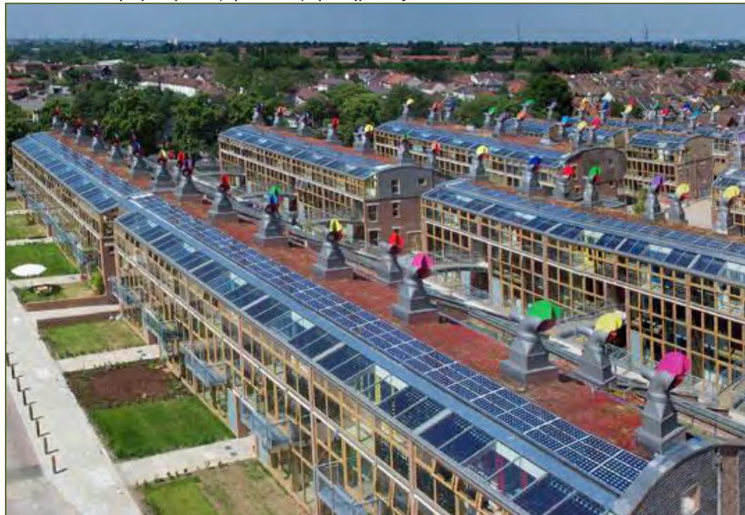
Εικ.3.1: Πανοραμική άποψη του συγκροτήματος BedZED.
