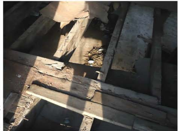
E50. Το κατεστραμμένο δάπεδο του ορόφου, όπως φαίνεται από τον όροφο. Πηγή: Προσωπικό Αρχείο
