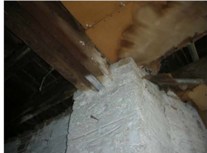
E33. Η σύνδεση της πέτρινης δοκού με το πέτρινο υποστύλωμα. Πηγή: Προσωπικό Αρχείο
