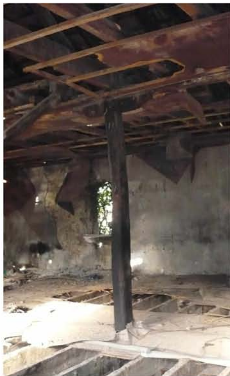
E27. Ξύλινο υποστύλωμα ορόφου. Πηγή: Προσωπικό Αρχείο
