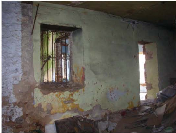
E46. Το καινούργιο τμήμα που κατασκευάστηκε λόγω της κατεδάφισης της λιθοδομής για την δημιουργία περασμάτων προς την προσθήκη του 1955. Πηγή: Προσωπικό Αρχείο
