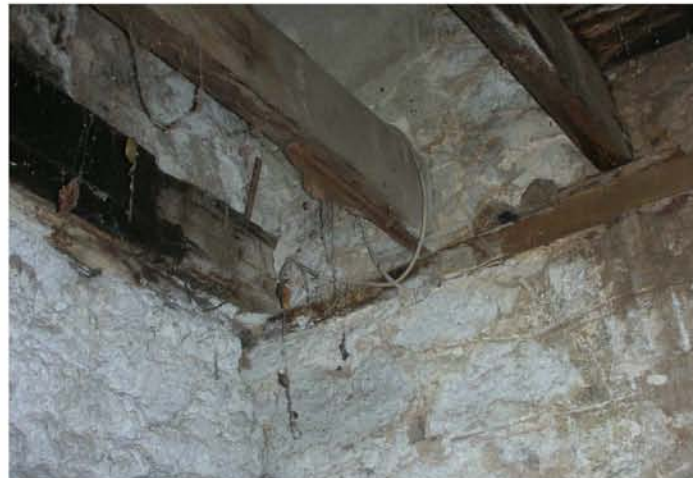
E35. Οι ξυλοδεσιές πάνω στις οποίες πατούν οι περαστές του πατώματος του ορόφου.
