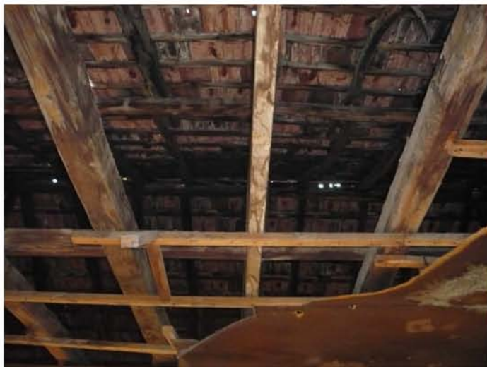
E29. Εσωτερική άποψη της ξύλινης στέγης. Πηγή: Προσωπικό Αρχείο
