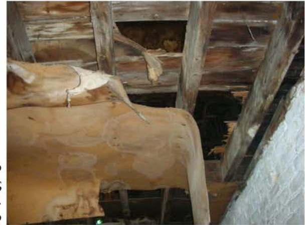
E48. Το κατεστραμμένο δάπεδο του ορόφου, όπως φαίνεται από το ισόγειο. Πηγή: Προσωπικό Αρχείο
