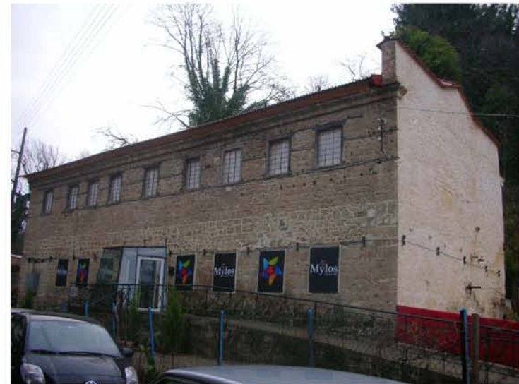
E5. Ο αλευρόμυλος των αδελφών Ντάλη σήμερα (μετατράπηκε σε νυκτερινό κέντρο). Πηγή: Προσωπικό Αρχείο.
