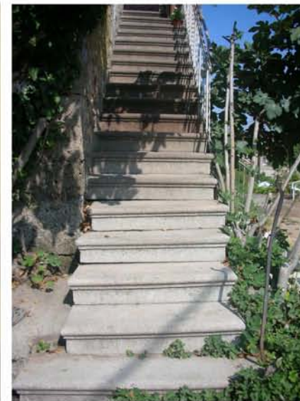
E42. Σκάλες του πρώην βιομηχανικού κτιρίου που αντικαταστάθηκαν από σκυρόδεμα. Πηγή: Προσωπικό Αρχείο
