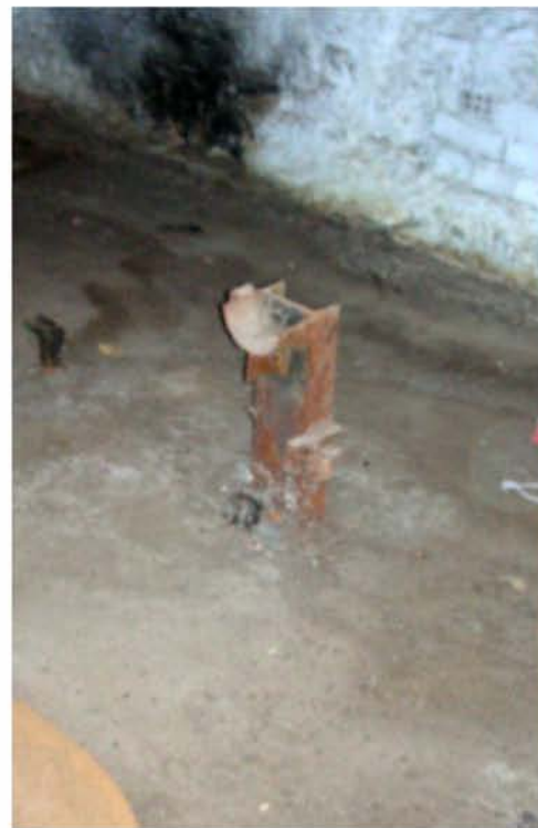
E28. Πάτωμα ισογείου από σκυρόδεμα. Πηγή: Προσωπικό Αρχείο
