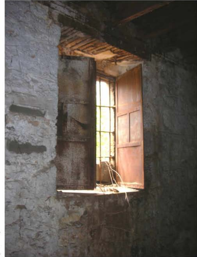
E38. Ένα από τα παράθυρα του κτιρίου στο οποίο έχουν διασωθεί τα μεταλλικά φύλλα και τα μεταλλικά κάγκελα. Πηγή: Προσωπικό Αρχείο
