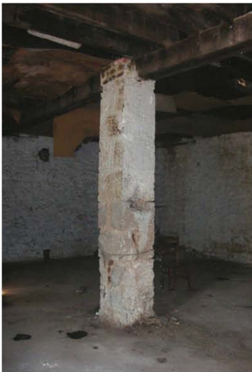
E26. Πέτρινο υποστύλωμα ισογείου. Πηγή: Προσωπικό Αρχείο
