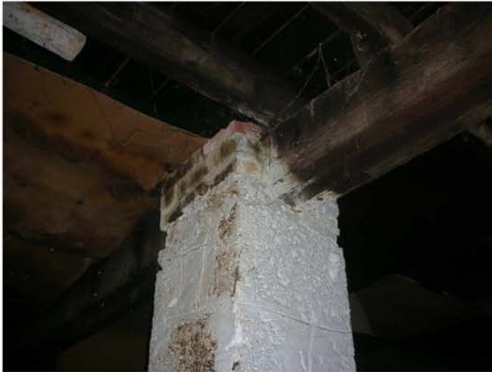
E32. Η σύνδεση της ξύλινης δοκού με το πέτρινο υποστύλωμα. Πηγή: Προσωπικό Αρχείο
