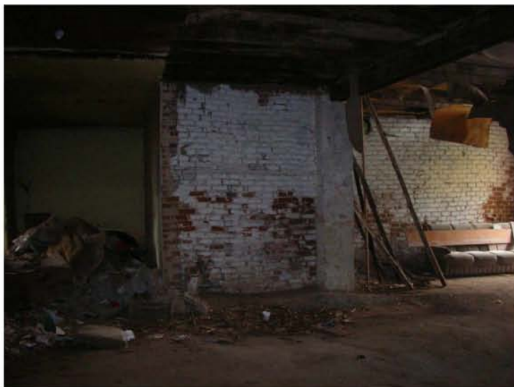
E44. Τα εσωτερικά χωρίσματα του κτιρίου κατασκευασμένα από οπτοπλινθοδομή. Πηγή: Προσωπικό Αρχείο
