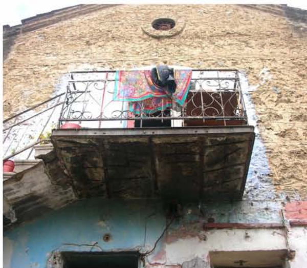
E43. Πρόβολος του πρώην βιομηχανικού κτιρίου που αντικαταστάθηκαν από οπλισμένο σκυρόδεμα. Πηγή: Προσωπικό Αρχείο
