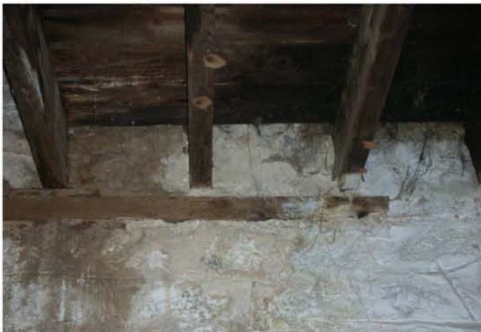
E34. Οι ξυλοδεσιές πάνω στις οποίες πατούν οι περαστές του πατώματος του ορόφου.
