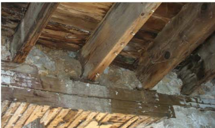
E36. Οι ξυλοδεσιές πάνω στις οποίες πατούν οι περαστές του πατώματος του ορόφου.
