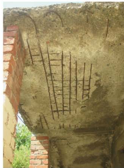
E41. Πρόβολος του πρώην βιομηχανικού κτιρίου που αντικαταστάθηκαν από οπλισμένο σκυρόδεμα. Πηγή: Προσωπικό Αρχείο
