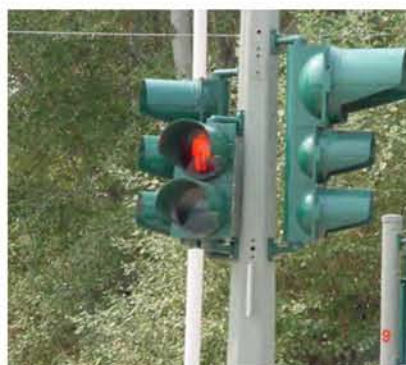
Φωτογραφία η –Σηματοδότης ρύθμισης κυκλοφορίας σε ιστό με βραχίονα (Φ200 Π – Φ200 ΟΧ – Φ300/200 ΟΧ / 3 πεδίων)
