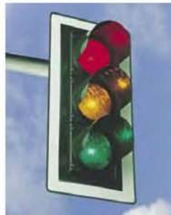
Φωτογραφία γ –Σηματοδότης ρύθμισης κυκλοφορίας σε ιστό με βραχίονα (Φ300 ΟΧ / 3 πεδίων)
