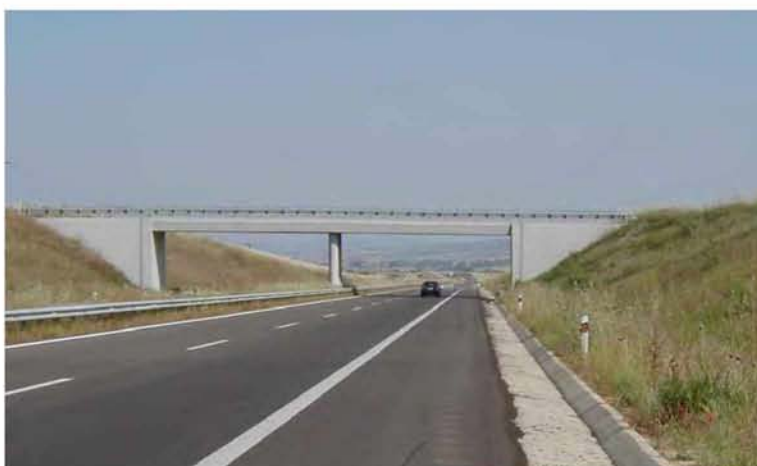
Φωτογραφία 3.13.3.α – Άνω διάβαση, Διασταυρούμενη οδός
