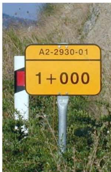
Φωτογραφία 3.11.3.β – Χιλιομετρικός δείκτης συντήρησης, ενδιάμεσος
