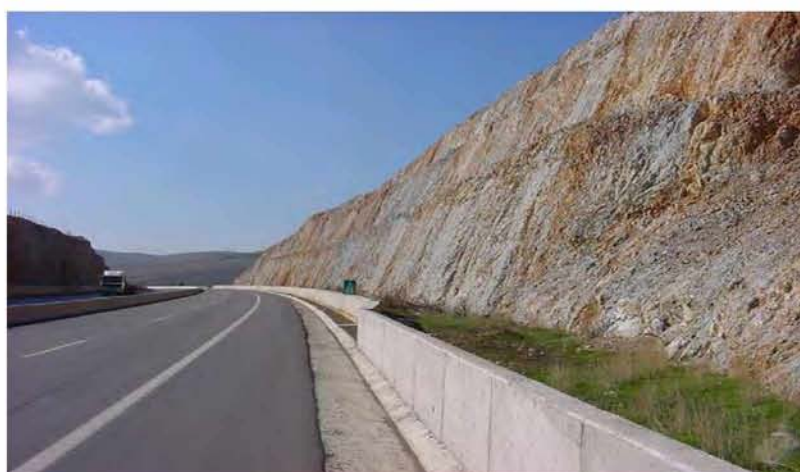
Φωτογραφία 3.7.1.β – Όρυγμα
