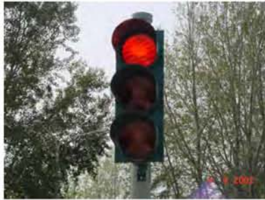
Φωτογραφία α –Σηματοδότης ρύθμισης κυκλοφορίας σε χαμηλό ιστό (Φ200 ΟΧ / 3 πεδίων)
