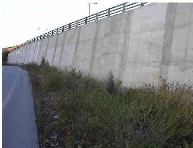
Φωτογραφία 3.13.4.α – Τοίχος αντιστήριξης
