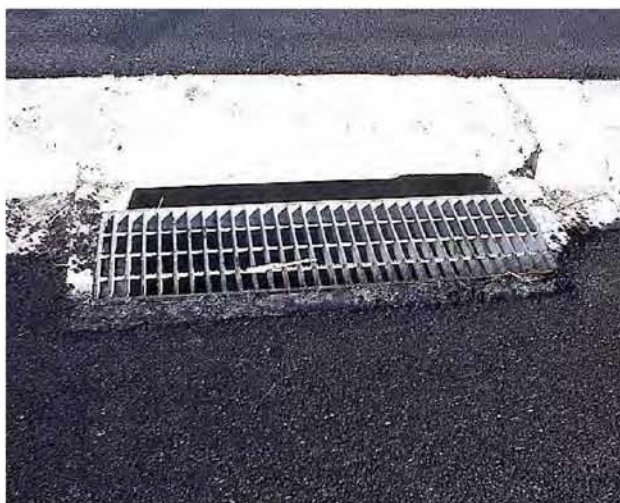
Φωτογραφία 3.6.1.α – Φρεάτιο, υδροσυλλογής με σχάρα
