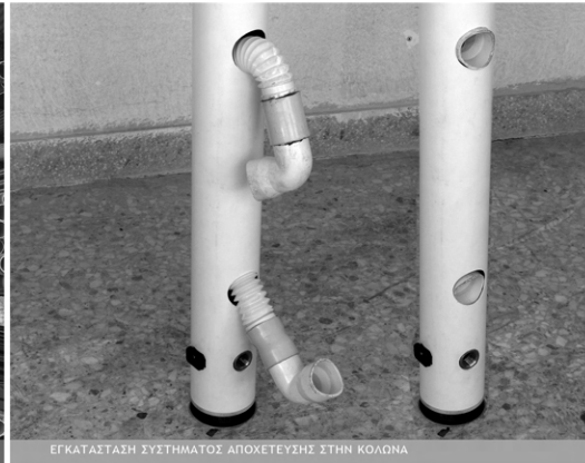
ΕΓΚΑΤΑΣΤΑΣΗ ΣΥΣΤΗΜΑΤΟΣ ΑΠΟΧΕΤΕΥΣΗΣ ΣΤΗΝ ΚΟΛΩΝΑ
