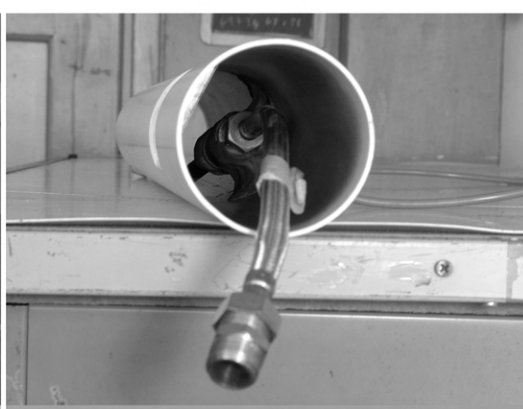
ΕΓΚΑΤΑΣΤΑΣΗ ΣΥΣΤΗΜΑΤΟΣ ΠΑΡΟΧΗΣ ΝΕΡΟΥ ΜΕ ΕΠΟΞΙΚΟ ΜΙΓΜΑ 2 ΣΥΣΤΑΤΙΚΩΝ
