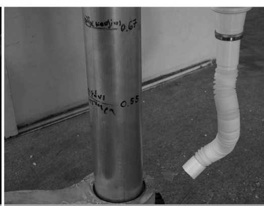
ΧΑΡΑΞΗ ΣΤΑΘΜΕΩΝ ΛΕΙΤΟΥΡΓΙΩΝ
