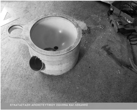
ΕΓΚΑΤΑΣΤΑΣΗ ΑΠΟΧΕΤΕΥΤΙΚΟΥ ΣΩΛΗΝΑ ΚΑΙ ΛΕΚΑΝΗΣ
