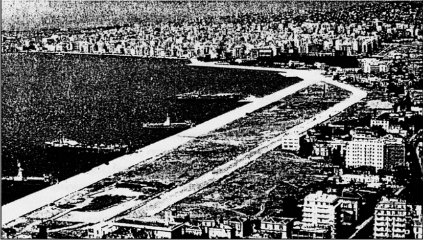
13. Η Νέα Παραλία κατά την διαδικασία επιχωμάτωσης (1960)
