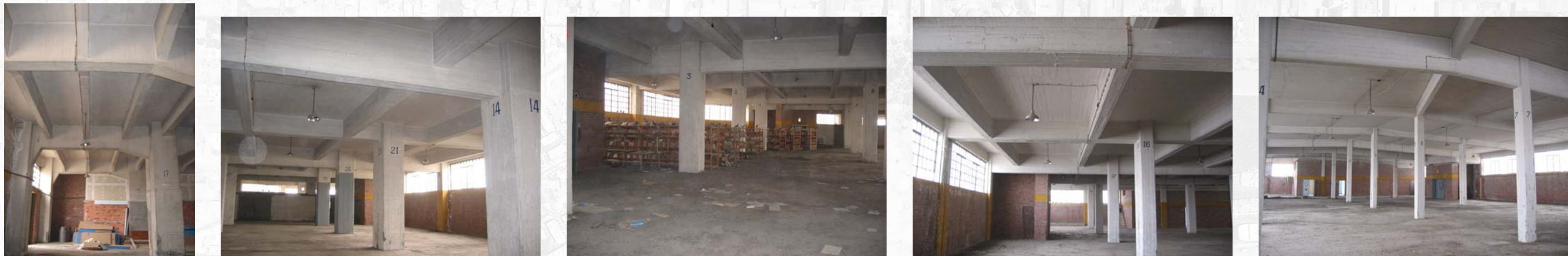
Εικόνες 10 – 14: (από αριστερά) Υποστυλώματα και δοκάρια από το ισόγειο έως τον τέταρτο όροφο.
