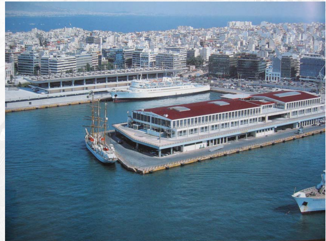
Εικ. 7: Άποψη των εγκαταστάσεων διοίκησης του Οργανισμού Λιμένος Πειραιώς σήμερα
