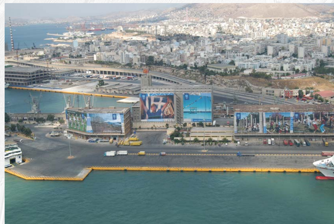
Εικ. 8, 9: Γενικές οπτικές προς το κτίριο
