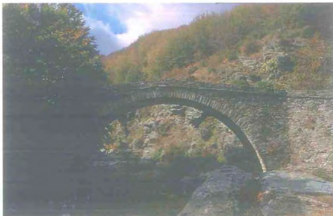
Εικ.21: Το γεφύρι Καρυάς στο ρέμα 'Καλιακούδα', στα όρια της περιοχής που προτείνεται να χαρακτηριστεί ως "Περιοχή Προστασίας της Φύσης".
