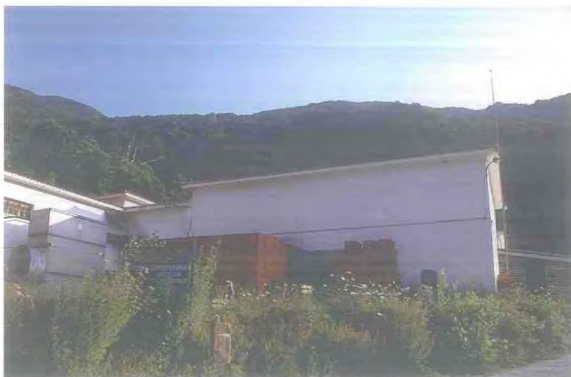
Εικ.5: Εγκαταστάσεις του αγροτικού συνεταιρισμού Μουρεσίου στο Ανήλιο.
