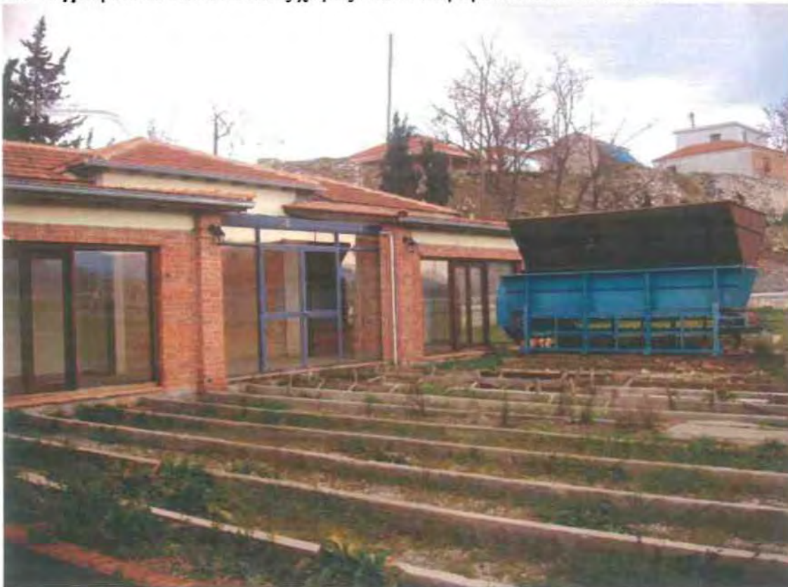
Φωτογραφία 43: Πολιτιστικός χώρος Πλινθοκεραμοποιείου Τσαλαπάτα
