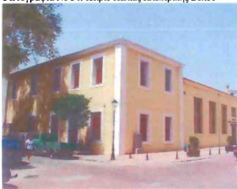
Φωτογραφία Νο 34: Κτίριο Παλιάς Ηλεκτρικής Βόλου
