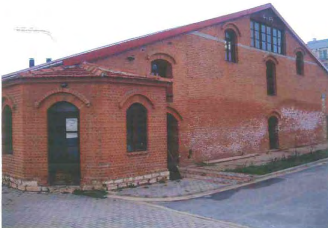
Φωτογραφία 41: Πολιτιστικός χώρος Πλινθοκεραμοποιείου Τσαλαπάτα
