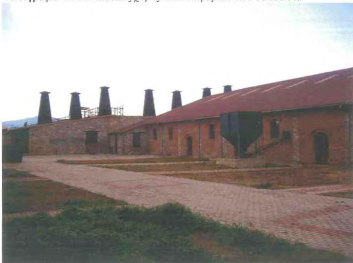
Φωτογραφία 42: Πολιτιστικός χώρος Πλινθοκεραμοποιείου Τσαλαπάτα
