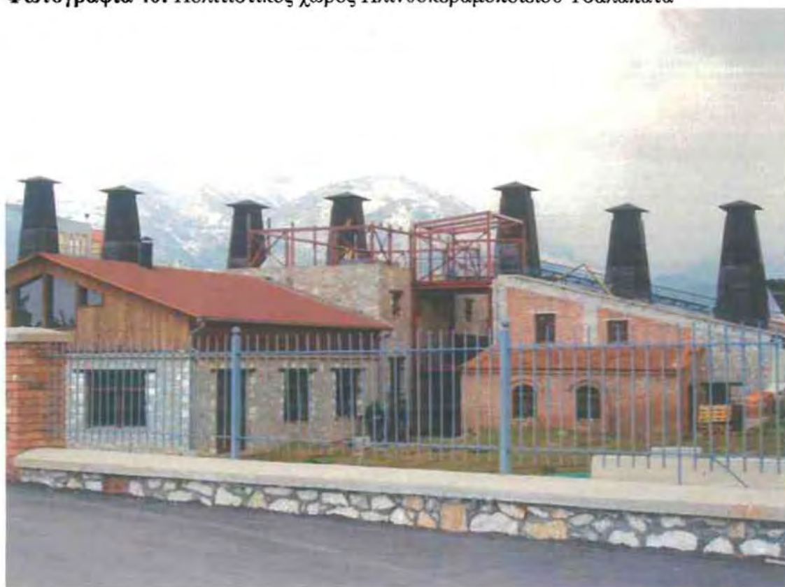
Φωτογραφία 40: Πολιτιστικός χώρος Πλινθοκεραμοποιείου Τσαλαπάτα
