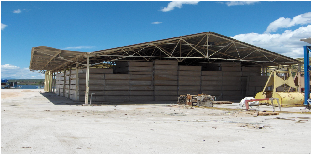
Εικόνα 18. Υφιστάμενος αποθηκευτικός χώρος Λιμένα
