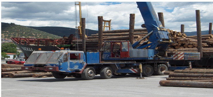
Εικόνα 21. Αυτοκινούμενος γερανός εν ώρα εργασίας
