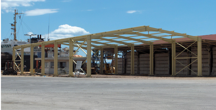
Εικόνα 20. Κατασκευή επέκτασης αποθήκης II σε εξέλιξη
