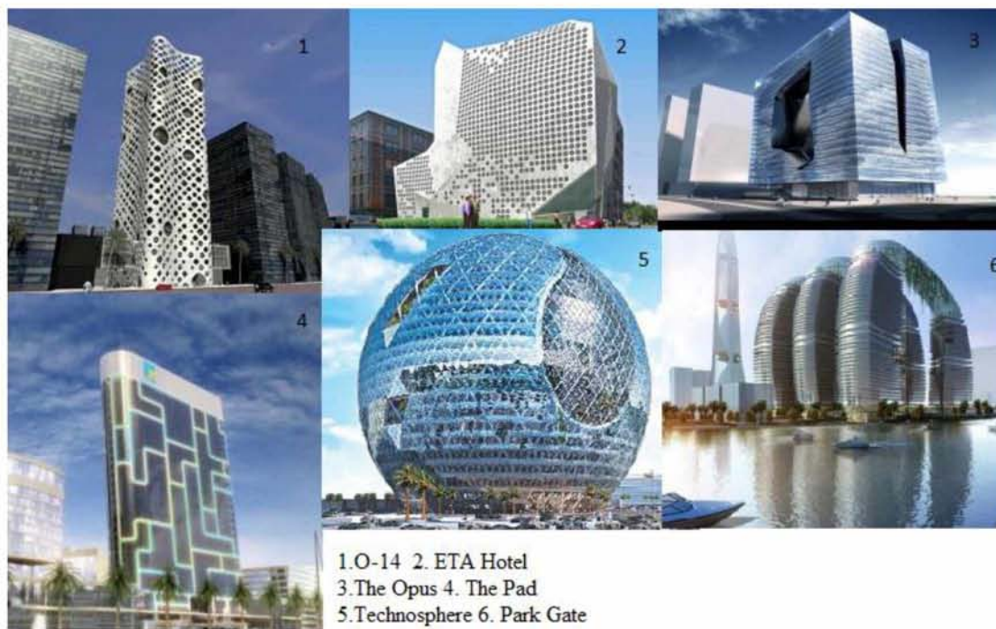
Εικόνα 3.4.3: Χαρακτηριστικά παραδείγματα κτιρίων Καινοτόμου Σχεδιασμού
