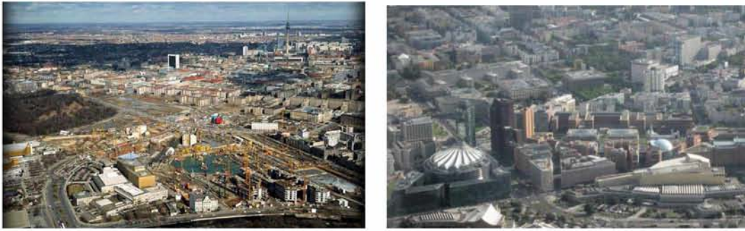
Εικόνα 3.2.1: Κατασκευαστικό τοπίο Potsdamer Platz / Η ανάπλαση της Potsdamer Platz
