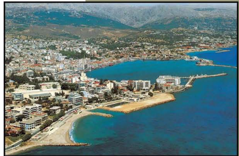
αεροφωτογραφία της περιοχής. (2003)
