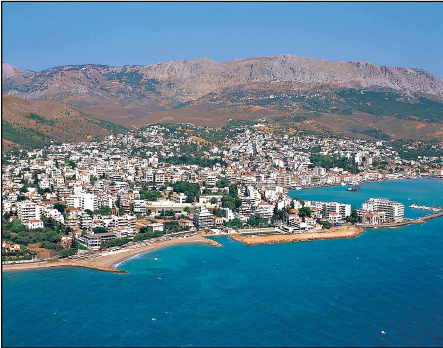
αεροφωτογραφία υφιστάμενης κατάστασης
