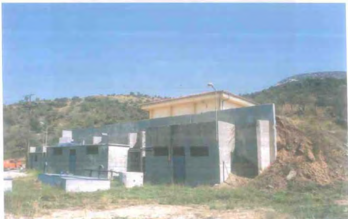
Δεξαμενή Σαρακηνού και άνωθεν αυτής το υδροηλεκτρικό.
