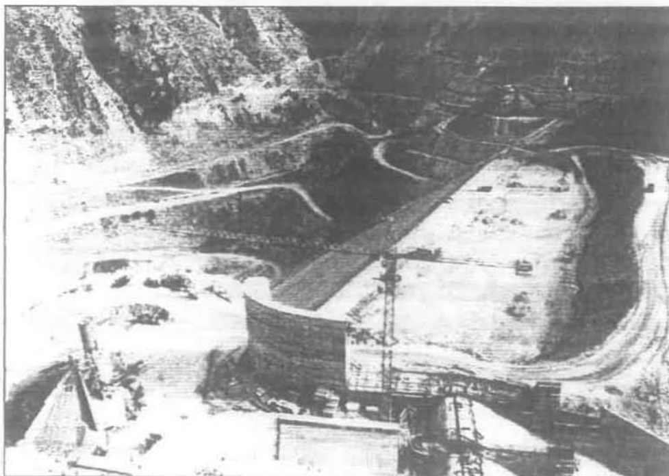
Φωτογραφία 2.6 : Κατασκευή αναχώματος (ΥΠΕ ΜΕΣΟΧΩΡΑΣ καλοκαίρι 1993 - Αρχείο ΔΕΗ).
