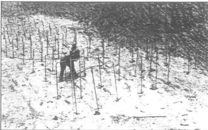
Φωτογραφία 1.1 : Αγκυρώσεις (ΥΠΕ ΜΕΣΟΧΩΡΑΣ 1992 – Αρχείο ΔΕΗ).
