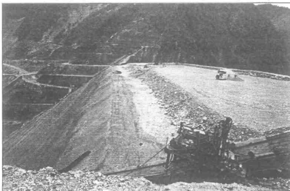
Φωτογραφία 2.7 : Άποψη του αναχώματος από το δεξί αντέρεισμα. Διακρίνεται και η στρώση του εκτοξευόμενου σκυροδέματος στο ανάντη πρανές (ΥΠΕ ΜΕΣΟΧΩΡΑΣ Δεκέμβριος 1993 - Αρχείο ΔΕΗ).
