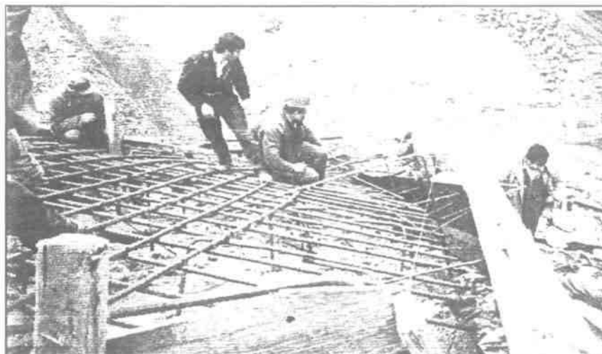
Φωτογραφία 1.2 : Οπλισμός πλίνθου (ΥΠΕ ΜΕΣΟΧΩΡΑΣ 1992 - Λιάκουρης).
