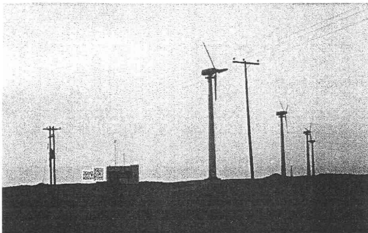
Ανεμογεννήτριες στο ακρωτήρι Καμαριώτισσας.
