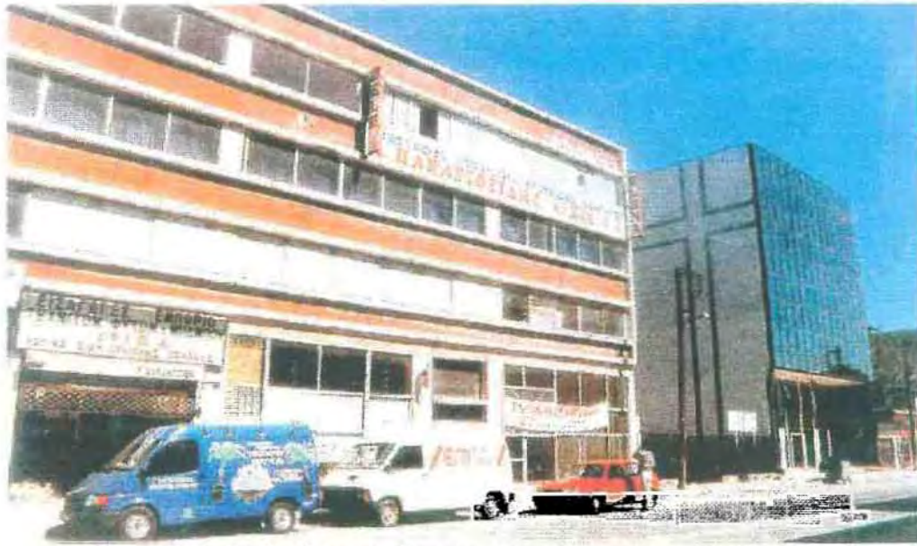
Φωτο 22: Πολυώροφο βιοτεχνικό κτίριο στην οδό Γιαννιτσών.
