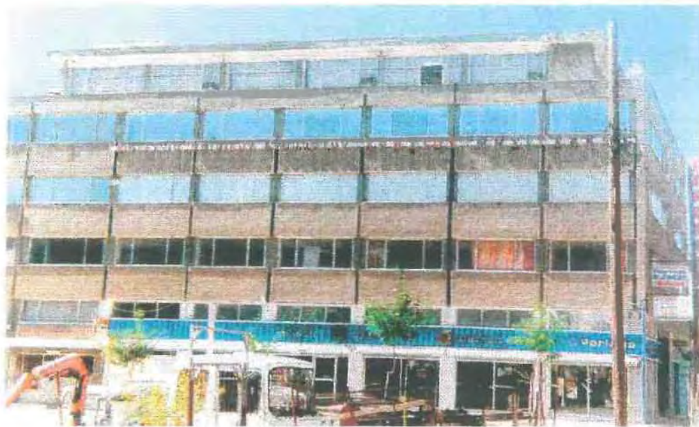
Φωτο 23: Πολυώροφο βιοτεχνικό κτίριο στην οδό Γιαννιτσών
