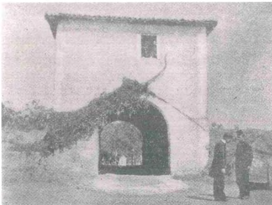
15. Το κτίριο – φυλάκιο στην πόρτα της Βρυσούλας από την μεριά της πόλης, 1900 (Ιδρυμα Ακτία Νικόπολις)
