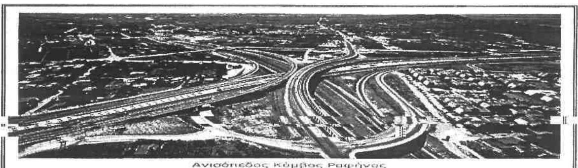
Ανισόπεδος Κόμβος Ραφήνας
