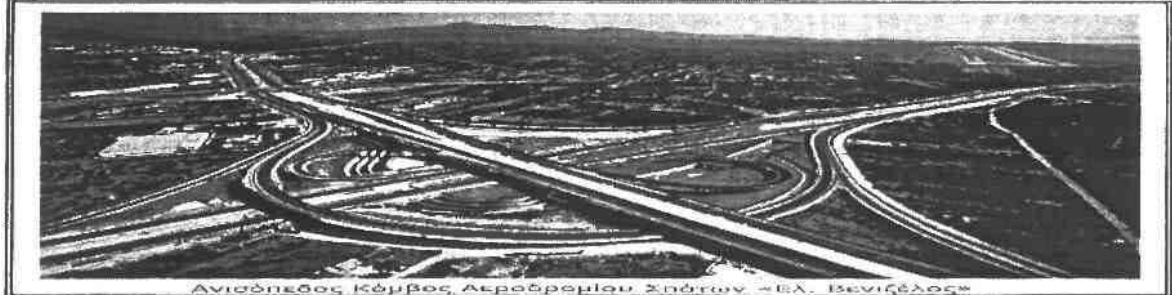
Ανισόπεδος Κόμβος Αεροδρομίου Σπάτων «Ελ. Βενιζέλος»
