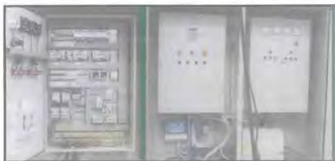
Σχ.3.7: Τοπικός Σταθμός Ελέγχου Διαρροών
