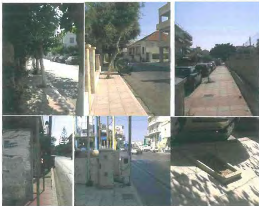
Εικόνα 20: Υφιστάμενη Κατάσταση Πεζοδρομίων
