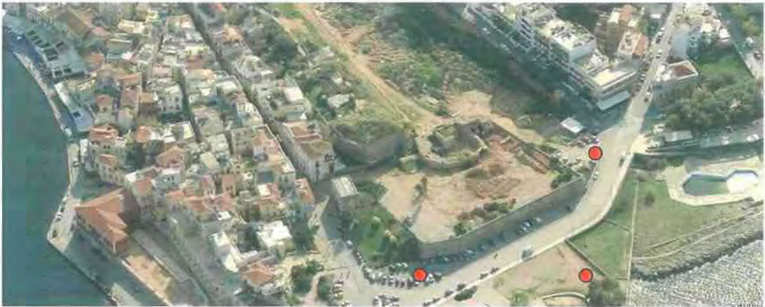
Εικόνα 28: Υφιστάμενη Κατάσταση Δυτικών Οχυρώσεων
