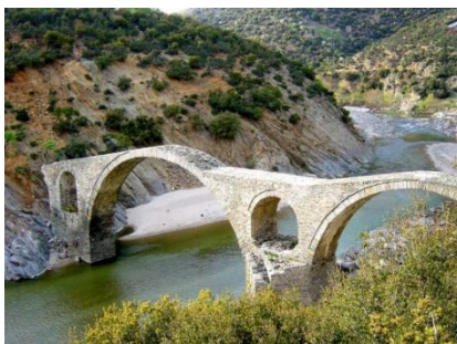
[24] Γέφυρα Ποταμού Κομφάτου
