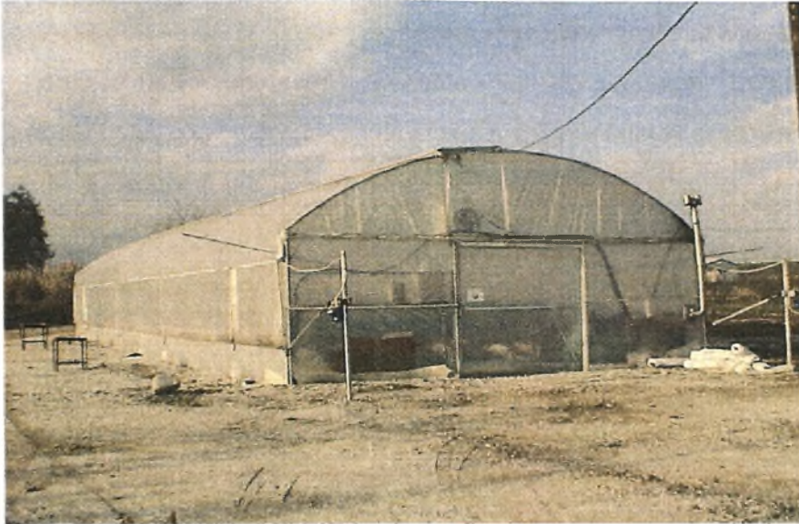
Εικόνα 3.1. Εξωτερική άποψη του πειραματικού θερμοκηπίου του Πανεπιστημίου Θεσσαλίας
