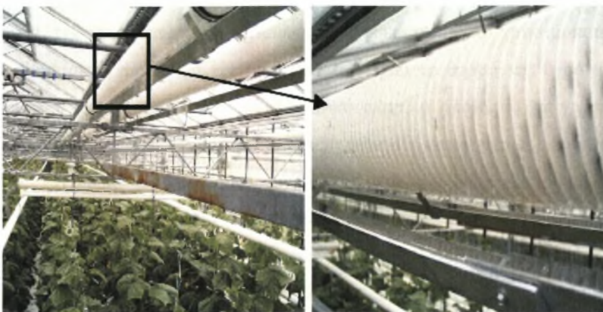
Εικόνα 2.5. Περυγωτοί σωλήνες τοποθετημένοι κάτω από την οροφή του θερμοκηπίου για τη συμπύκνωση του υγρού αέρα στην επιφάνειά τους. Στη δεξιά
