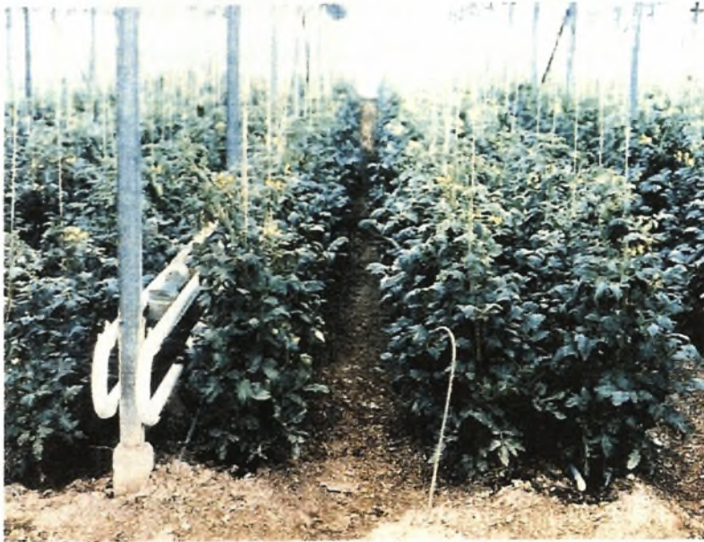
Εικόνα 2.2. Σωλήνες κατανομής της θερμότητας στο χώρο του θερμοκηπίου, τοποθετημένοι κατά μήκος της σειράς των στύλων (κλασικό σύστημα) ( http://www.ekk.aua.gr/seminar/seminar09.pdf )
