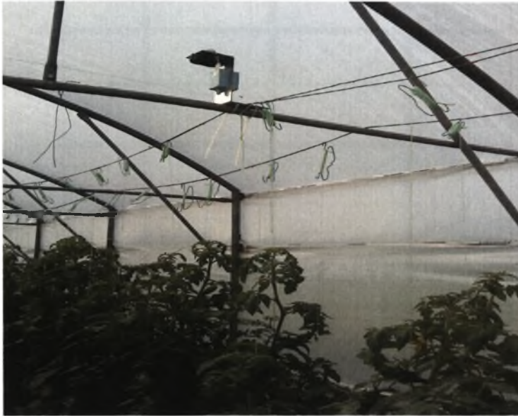
Εικόνα 3.7. Ασύρματος αισθητήρας τοποθετημένος στα 2,5 μέτρα από την επιφάνεια του εδάφους
