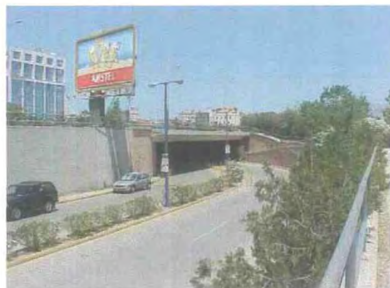
Φ.64 Εξωτερική υπόγεια διέλευση οχημάτων προς το ΣΕΦ
