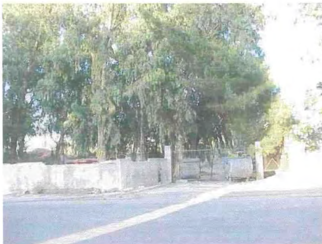
Φ.43 Χώρος στάθμευσης απορριμματοφόρων
