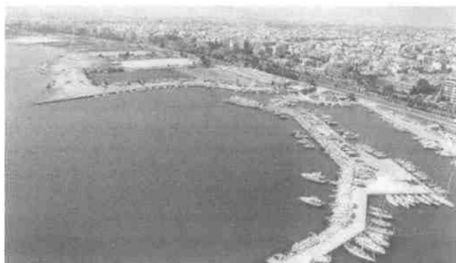
Φωτογραφία 5: Γενική άποψη της Λεωφόρου Ποσειδώνος και των επιχωματώσεων.
