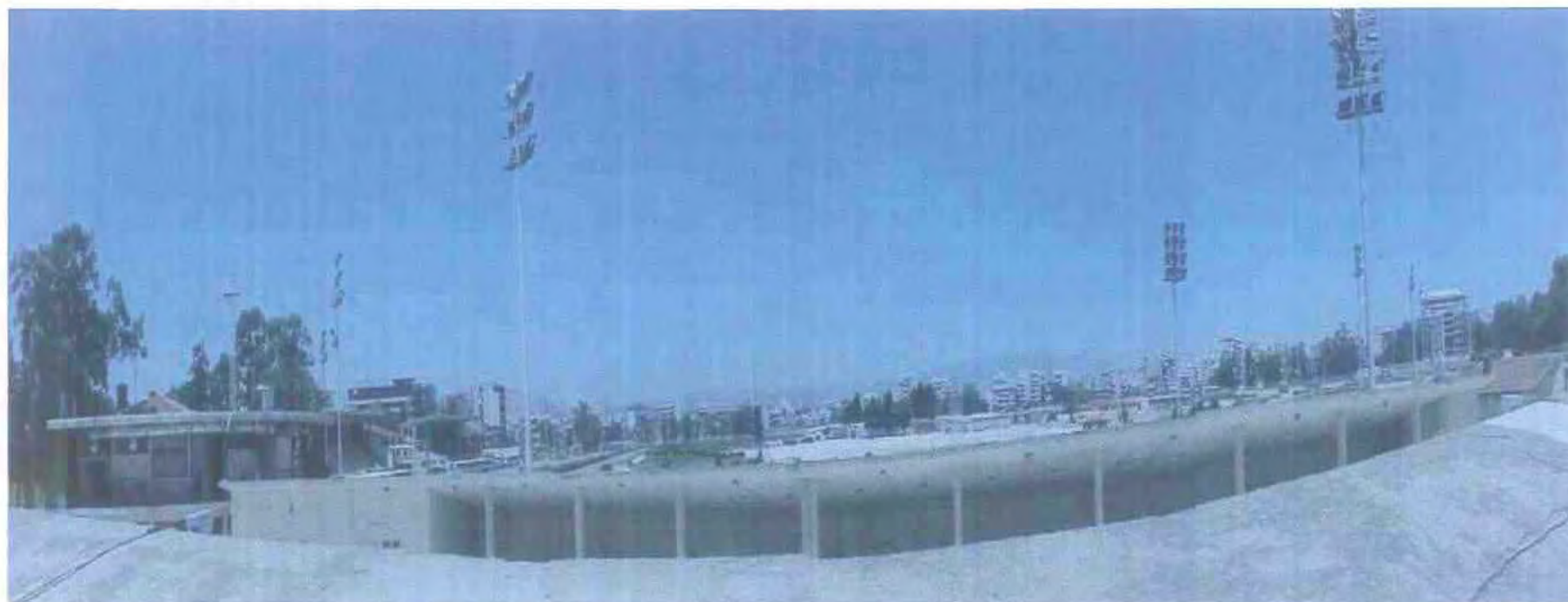
Φ.59 Άποψη του εσωτερικού χώρου του Ιπποδρόμου
