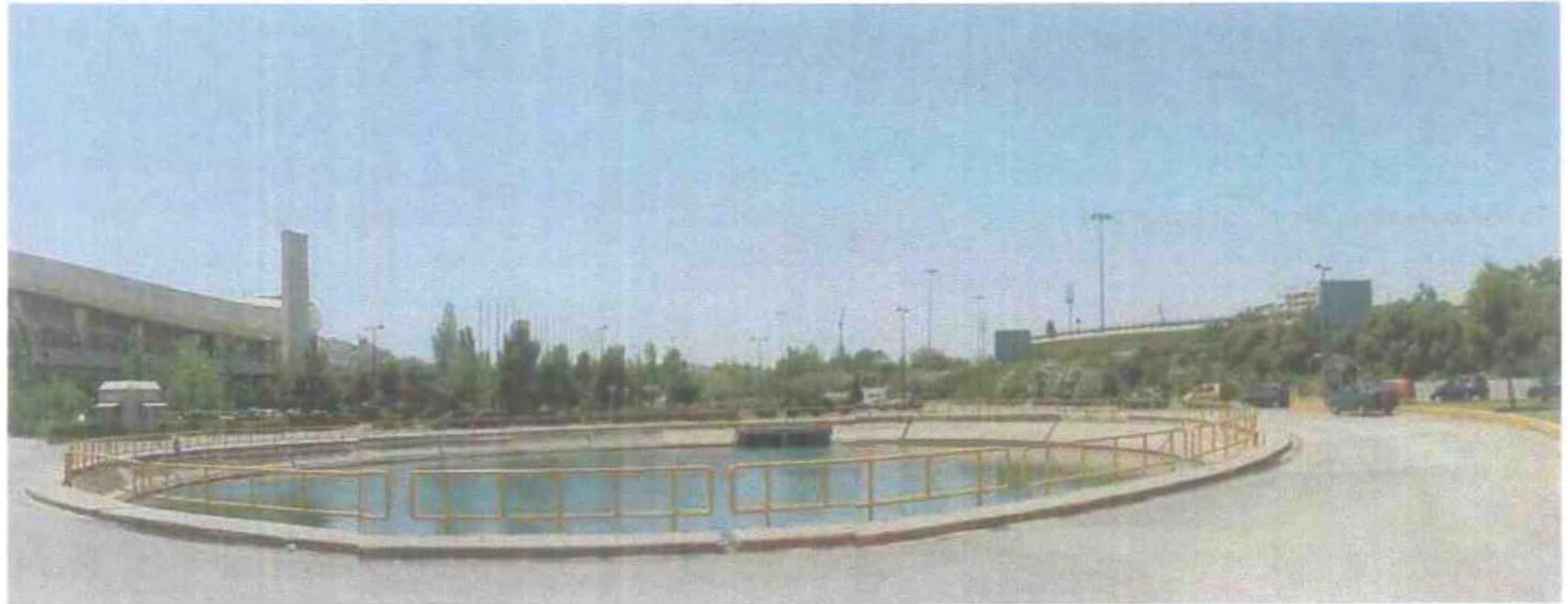
Φ.65 Round about στον εξωτερικό χώρο του ΣΕΦ
