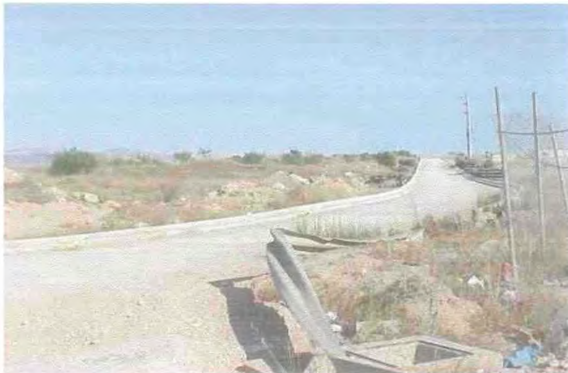
Φ.13 Υπερυψωμένος δακτύλιος μετά το εργοτάξιο στην εκβολή του Κηφισού
