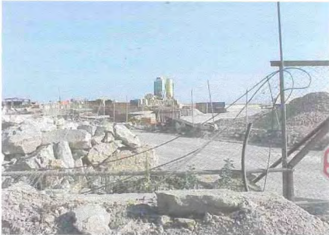
Φ.12 Εργοτάξιο πάνω στην εκβολή του Κηφισού
