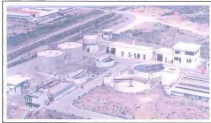
Εικόνα 11: Εγκαταστάσεις Επεξεργασίας λυμάτων Αλεξανδρούπολης
