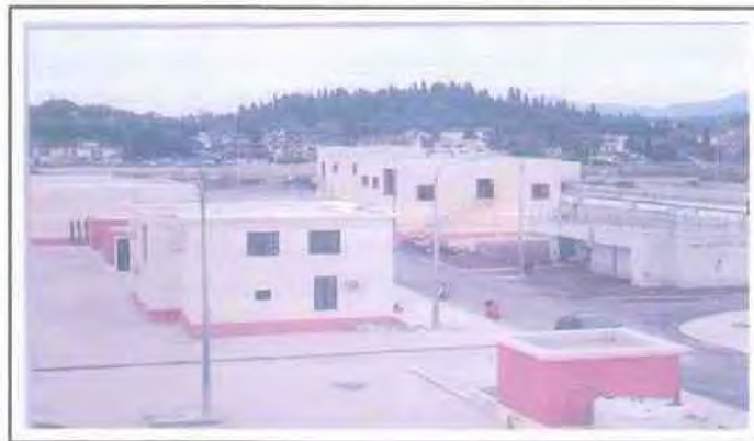
Εικόνα 13: Εγκαταστάσεις επεξεργασίας λυμάτων Κέρκυρας
