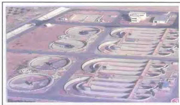
Εικόνα 12: Εγκαταστάσεις Επεξεργασίας λυμάτων Κορίνθου - Λουτρακίου
