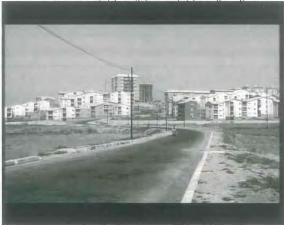
Εικόνα 31: Αδιαμόρφωτοι χώροι. Η περιφέρεια της πόλης.
