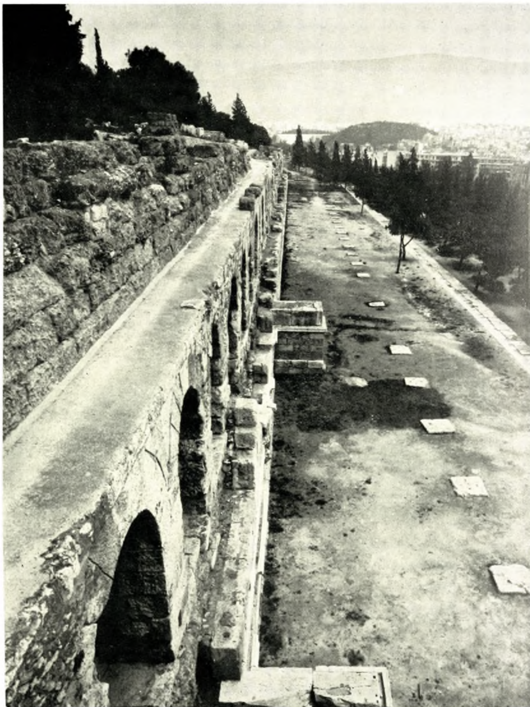
Ἀθήναι. Στοὰ Εὐμένους: Ὁ χώρος μετὰ τὰς ἐργασίας διαμορφώσεως
