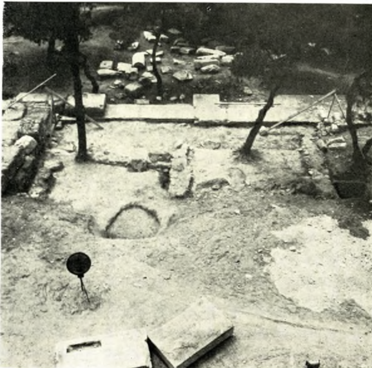
Ἄθῆναι. Στοά Εὐμένους: α. Ὁ χώρος πρὸ τῶν ἐργασιῶν διαμορφώσεως, β. Οἰκία κατὰ τὴν ΝΑ. γωνίαν
