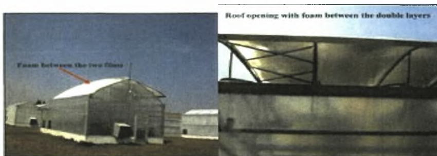
Εικόνα 12: Αριστερά διακρίνουμε το θερμοκήπιο εφαρμογής ενώ δεξιά το αφρό που έχει εφοδιαστεί ανάμεσα στα δύο φύλλα πολυαιθυλενίου (Aberkani, 2009).
