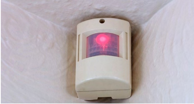
Εικόνα 8-Οι αισθητήρες κίνησης τοποθετούνται σε σημεία που μπορούν να ελέγξουν περιμετρικά κάποια ανοίγματα όπως οι πόρτες και τα παράθυρα
